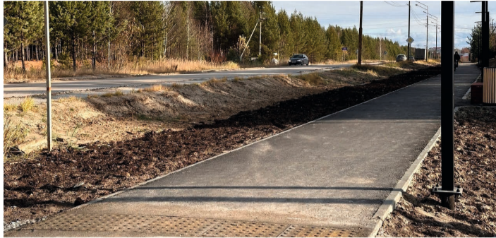
Вместо бетонных плит, прилегающих прямо к проезжей части, на ул. Киевской в Советском появился удобный, асфальтированный тротуар
