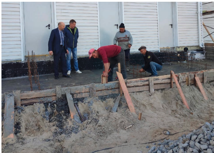
В Приобье полным ходом идёт реконструкция здания лыжной базы
