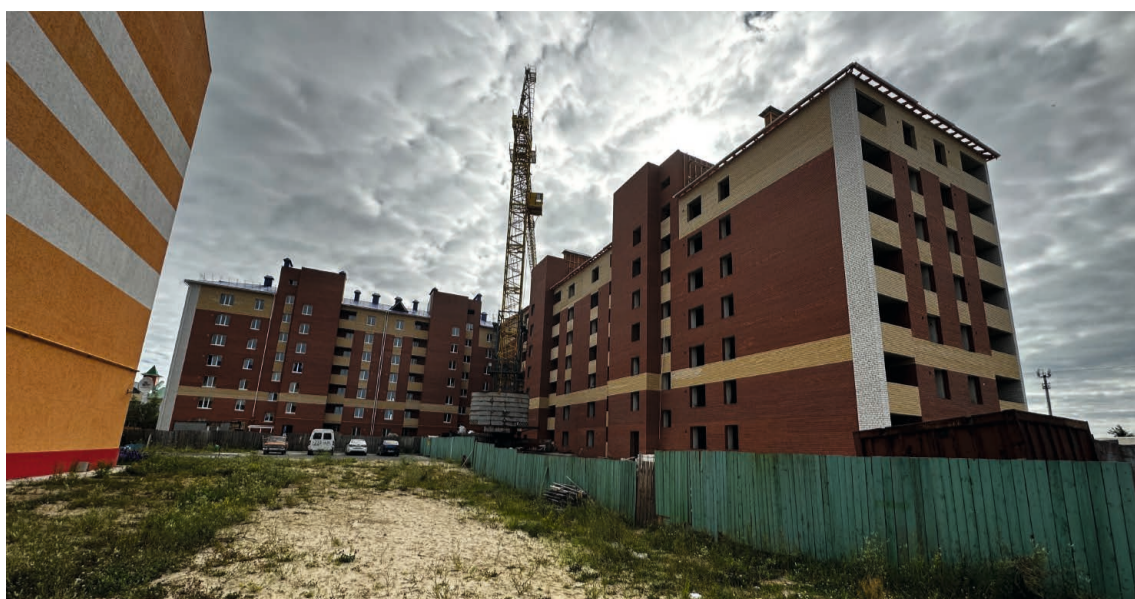
Компания «Дружба Н» ведёт несколько строек, в том числе на ул. Трассовиков в Советском
