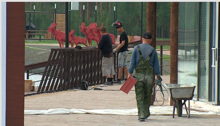
Сборка декоративного ограждения набережной
