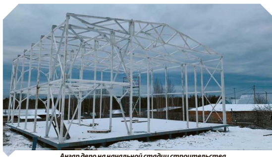
Ангара депо на начальной стадии строительства.
