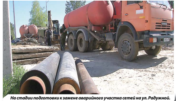
На стадии подготовки к замене аварийного участка сетей на ул. Радужной.
